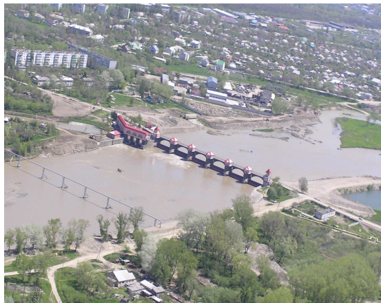
Невинномысский гидротехнический узел
